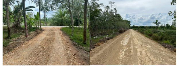
รูปภาพดำเนินการแล้วเสร็จ
