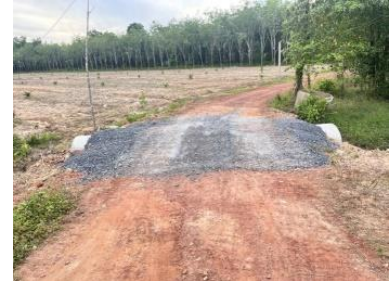
รูปภาพดำเนินการแล้วเสร็จ
