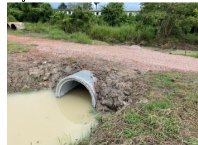
รูปถ่ายดำเนินการแล้วเสร็จ
