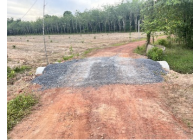
รูปถ่ายดำเนินการแล้วเสร็จ
