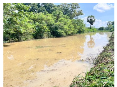
รูปภาพดำเนินการแล้วเสร็จ
