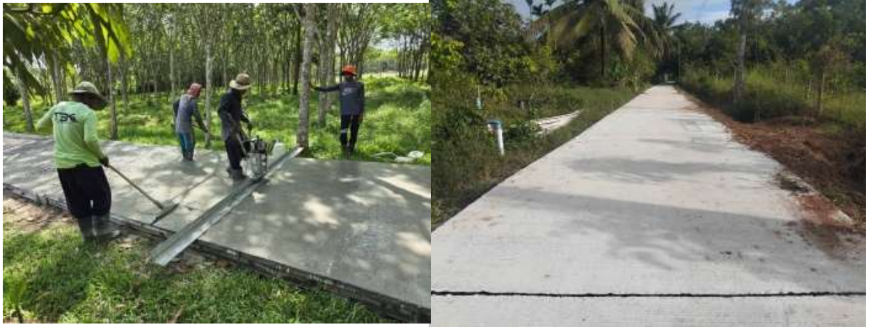
๘.โครงการก่อสร้างถนนคอนกรีตเสริมเหล็กสายซอยบ้านนายบุญชู แก้วนุ้ย หมู่ที่ ๑๐ ตำบลปันแต
