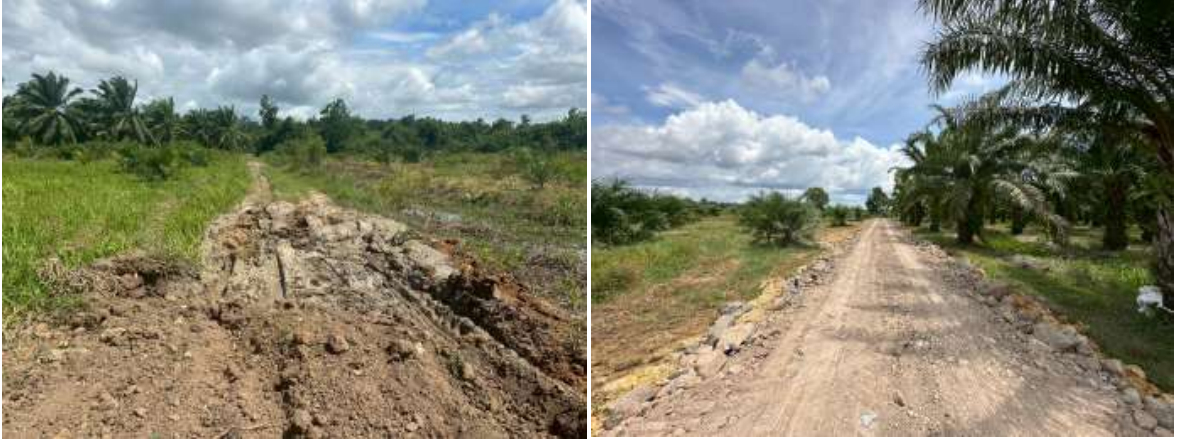
๑๓.โครงการขุดเปิดถนนสายมาบathom - มาบแมว หมู่ที่ ๘ ตำบลปันแต
