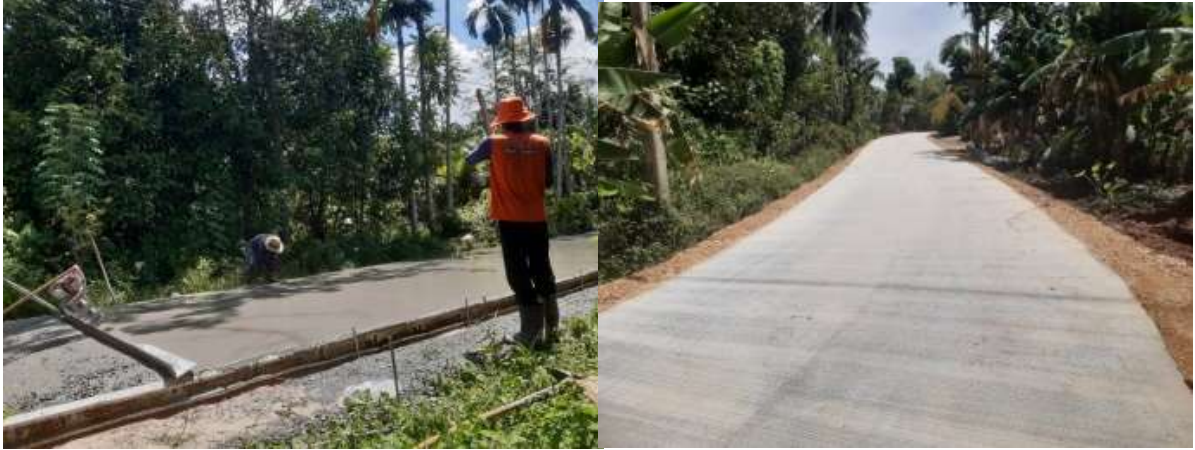
๗. โครงการก่อสร้างถนนคอนกรีตเสริมเหล็กสายโนไร่ - มาบปลวกขาม หมู่ที่ ๖ ตำบลปันแต
