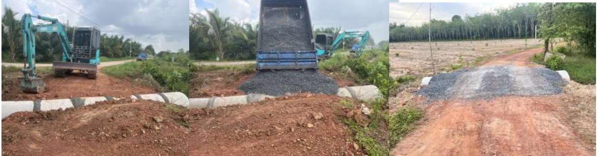
๑๕.วางท่อระบายน้ำ คสล.มาตรฐาน(มอก.ชั้น๓) ถนนสายไสปรังค์-บ้านนายสุพัฒน์ หมู่ที่ ๖ ตำบลปันแต
