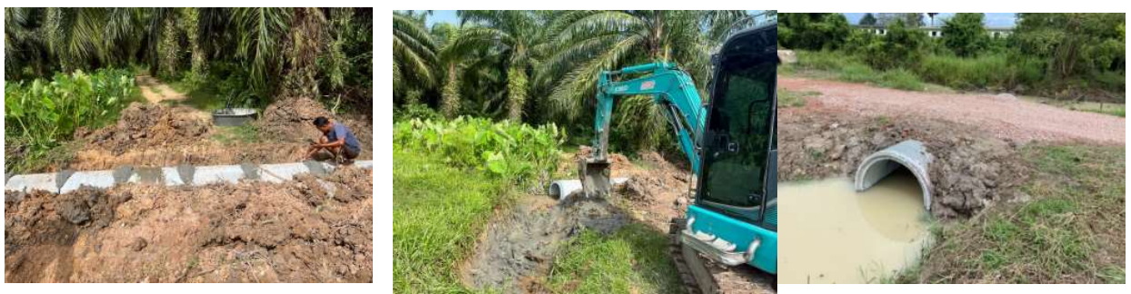
๑๖.วางท่อระบายน้ำ คสล.มาตรฐาน(มอก.ชั้น๓)ถนนสายสะพานเหล็กเลียบบเหมือนไฟฟ้า หมู่ที่ ๑ ตำบลปันแต
